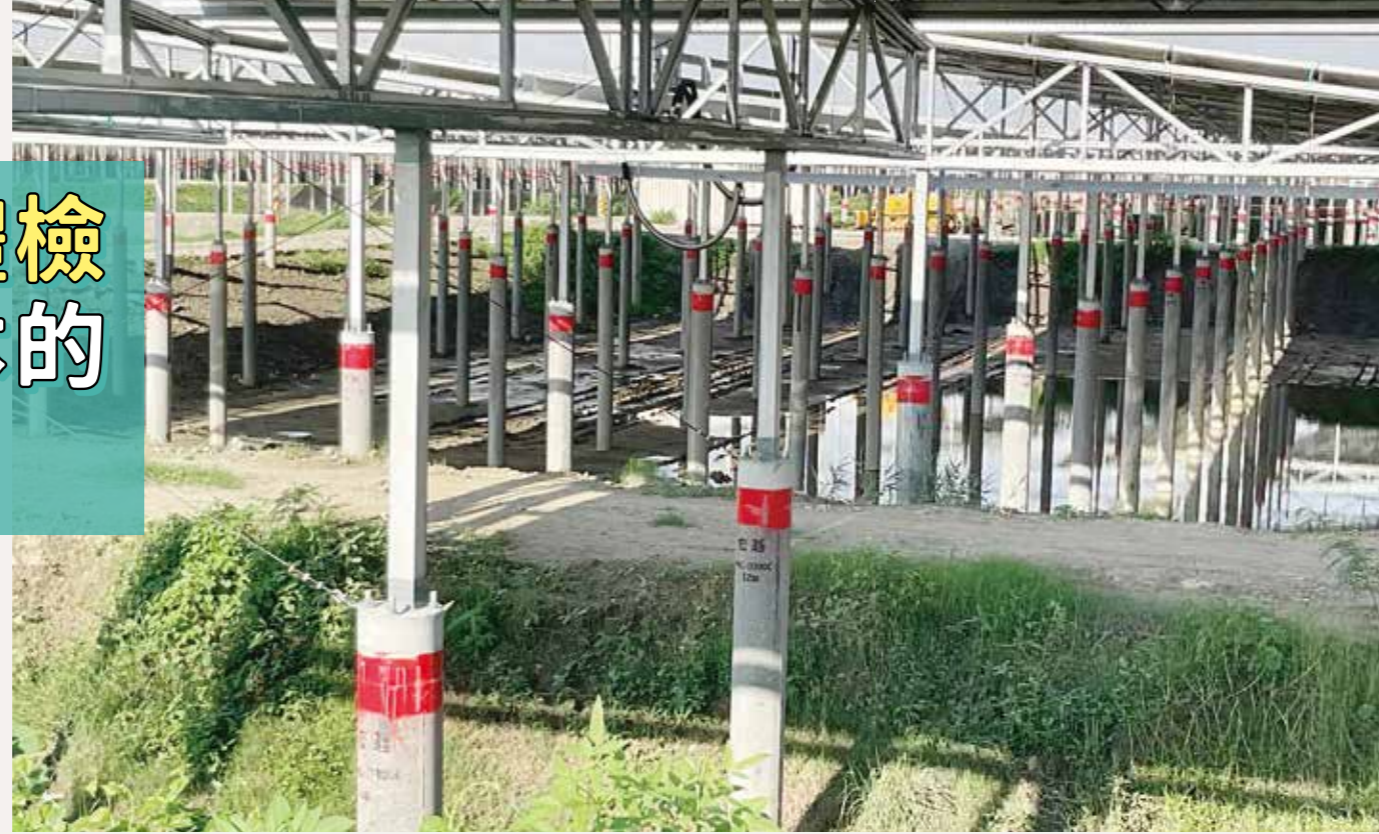
以發電為主的漁電案場，密佈的基樁相當不利於養殖作業（圖片提供／彭桂枝）
