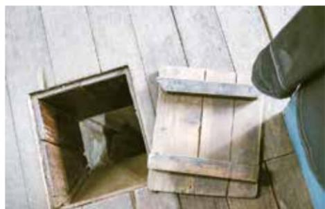
為減少搬運，東邦紅茶過去設有投茶孔，可將茶菁投入直接接到揉捻機進行揉製。
