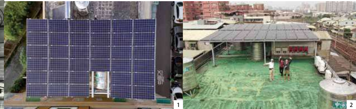
1 天空1號，水塔與太陽能板共融。（綠電合作社提供） 2 在既有合法建築屋頂上建置太陽能板，讓用電與發電成為每位公民的日常風景。（攝影／王維笑、綠電合作社提供）
