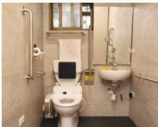
浴室中有多處扶手，可避免跌倒；警鈴設置在馬桶前面的牆壁上，坐在馬桶上可以輕鬆按到；洗臉臺的鏡子微微向下傾斜，方便使用輪椅者或坐在椅子上時使用。
