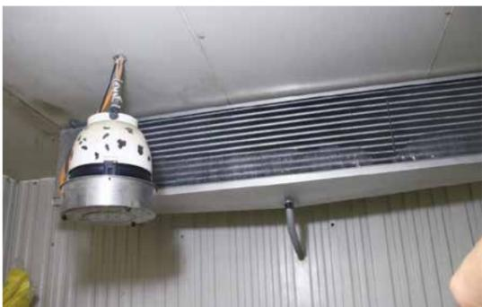
新型的冷藏庫，天花板的銅管採滲透式，冷空氣遇到熱空氣會轉換成水蒸氣，讓水蒸氣慢慢下沉，溫度緩慢下降，紅蘿蔔不易失水，可維持冷藏品質。
